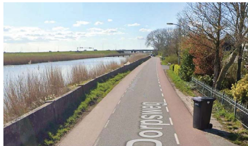
De Dorpsweg van Oudendijk met links de betonmuur. Google Street View.
