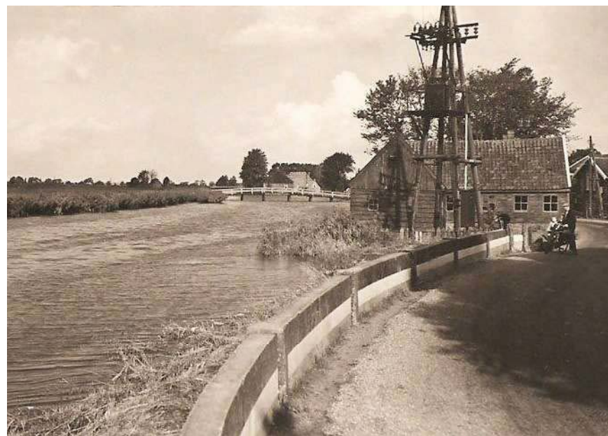
Het begin van de betonmuur ter hoogte van de kerk. Vermoedelijk is de muur vanwege de bocht in de weg naderhand voor het verkeer rood en wit geverfd. Collectie Hemony.
