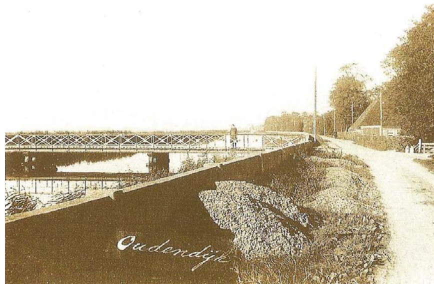
Komend vanaf Schardam zien we hier het tracé van de betonmuur dat is gebouwd in 1918. Op de achtergrond de brug bij het Tolhek. Collectie Hemony.
