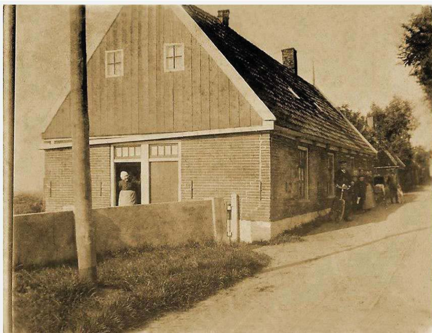
Het Armenhuis van Oudendijk, nu met de in 1910 gebouwde betonmuur. Collectie Hemony.
